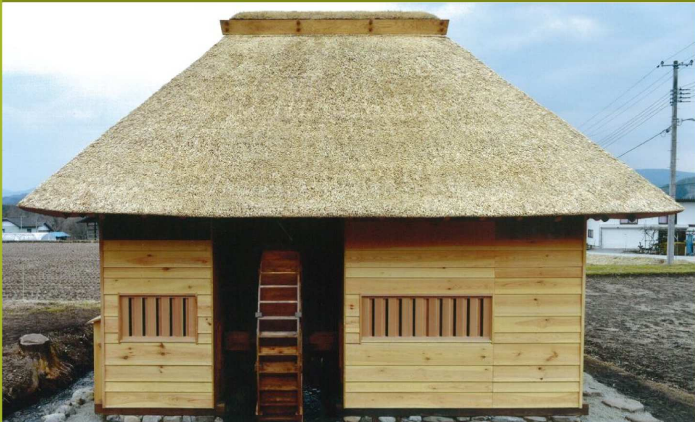
国選定重要文化的景観 重要構成要素 遠野市「山口の水車小屋」 (外壁等に当組合の南部あかまつを使用)
