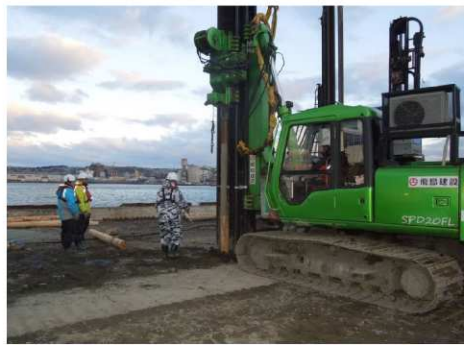
丸太打設の状況
